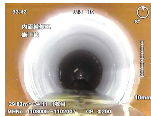
上段:内面補修前 下段:内面補修後
