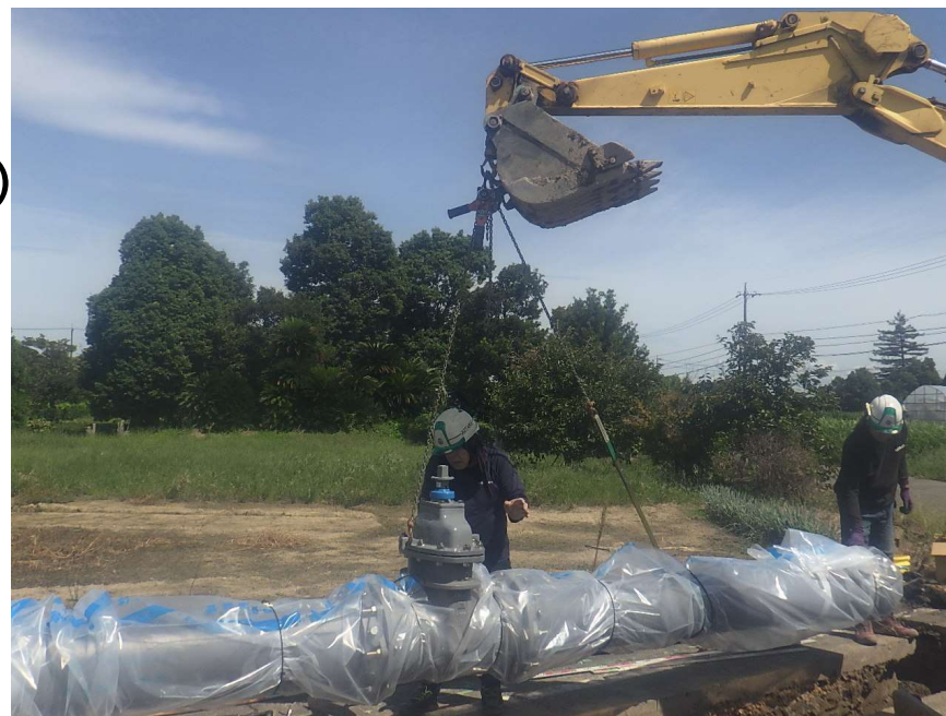
基幹管路耐震化工事の様子
