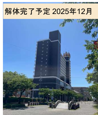
現状建物全景
