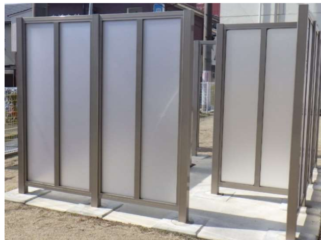
クランクを設け煙の流出に配慮
