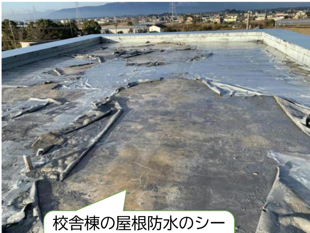
校舎棟の屋根防水のシートが劣化により全面的にめくれた状態
