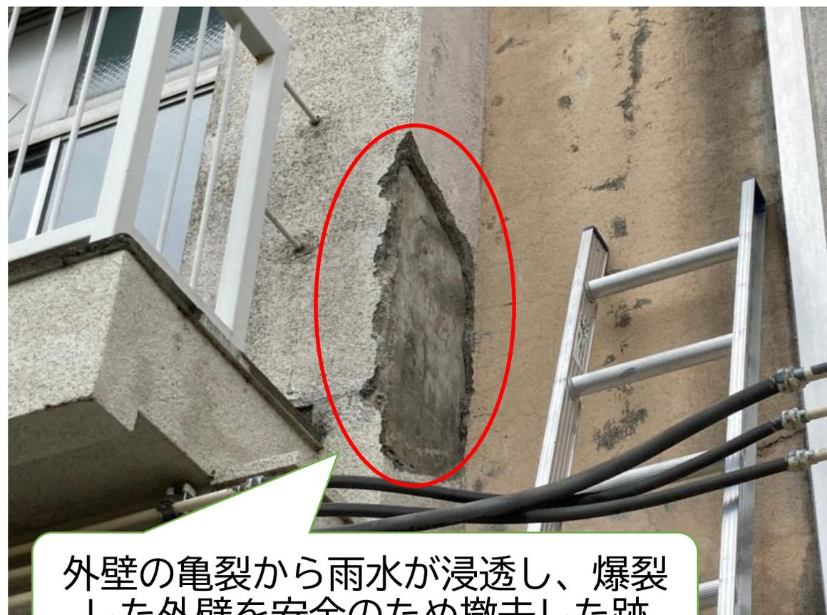
外壁の亀裂から雨水が浸透し、爆裂した外壁を安全のため撤去した跡
