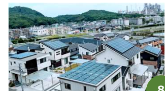
建物の屋根への太陽光導入
