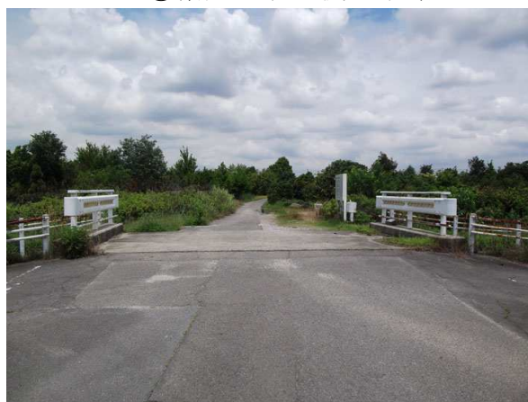
⑭指定地南端水路と県道間の道路
