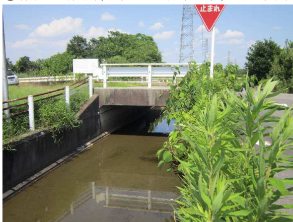
⑬指定地南端の橋梁（椎木橋）
