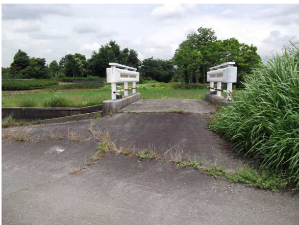
⑦指定地東側、水路沿いのガードレール
