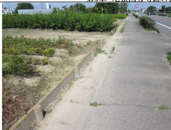
⑩指定地南側、県道沿いの側溝
