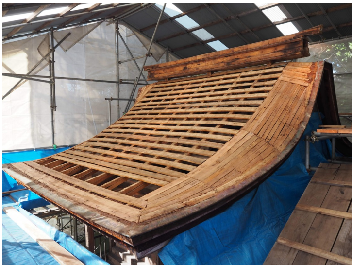
鎮守堂の桧皮葺を解体したところ
