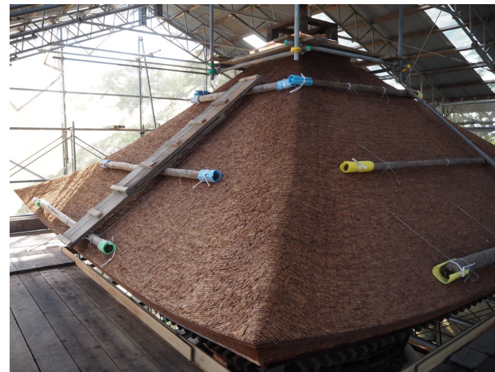
檜皮を葺き替えました 屋根に取り付いているのは足場です
