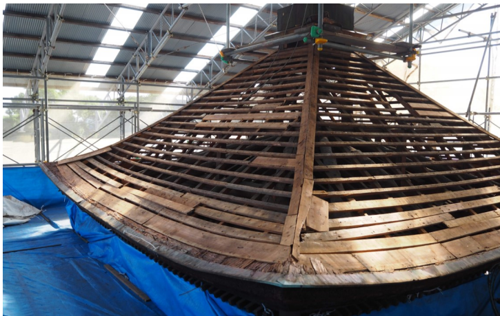
多宝塔の桧皮葺を解体したところ
