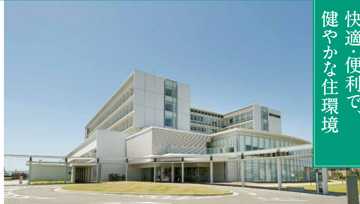
稲沢市民病院 Inazawa Municipal Hospital
