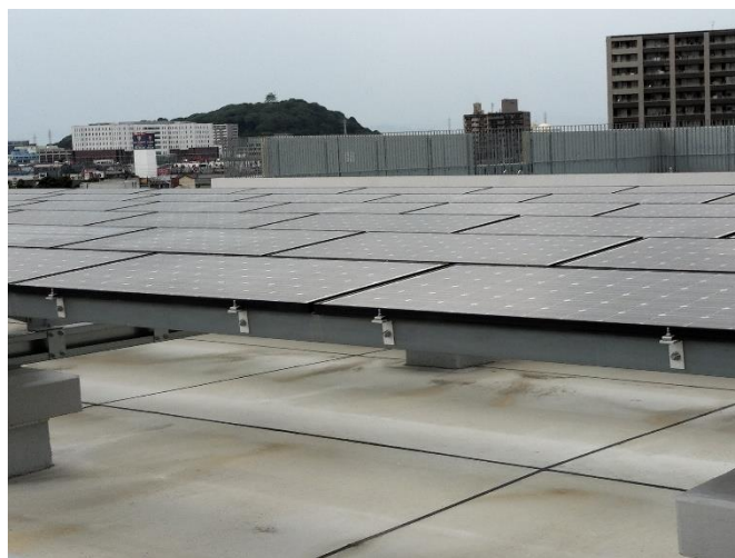
（屋上に設置された太陽光発電設備）【小牧市立小牧南小学校】
