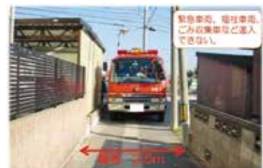
岡崎市の狭隘道路の様子
