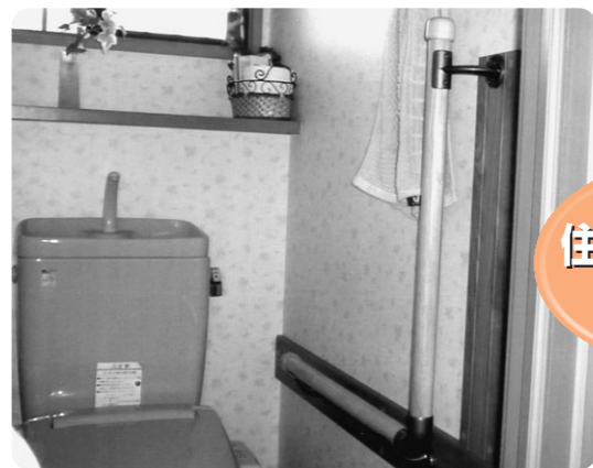
手すりの設置
