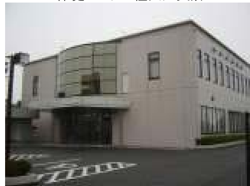
■ 保健センター祖父江支所
