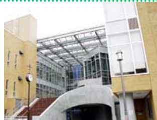
志木市立志木小学校・いろは遊学図書館・いろは遊学館(公民館)
