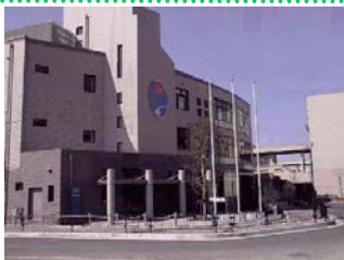
茨木市立庄栄小学校・庄栄図書館・コミュニティセンター
