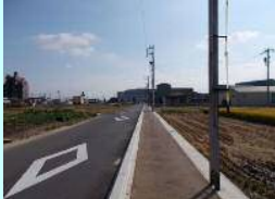
高質空間形成施設（カラー舗装） 市道3021号線
