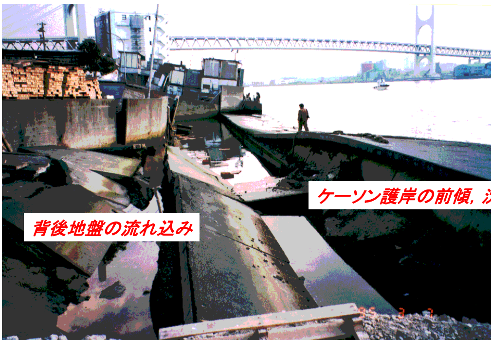
ケートン岸壁の倒壊と背後地盤の側方流動 (阪神淡路大震災)
