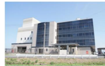
稲沢市環境センターの発電電力の有効活用
