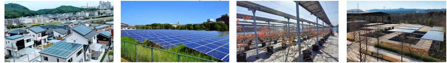
建物の屋根への導入
