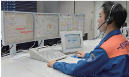
119番通報の受付を行います。指令管制業務に関わるすべての有線および無線通信を取り扱うとともに、自動出動指定装置、地図等検索装置を収容し、連携して運用を行います。
