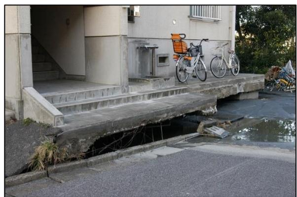
液状化により貯水タンクが浮き出し、建物と道路の間に段差ができています。(写真:「浦安震災アーカイブ」より)
