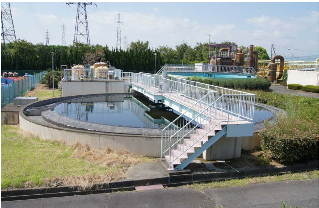
稲 沢 市 平 和 浄 化 セ ン タ ー
