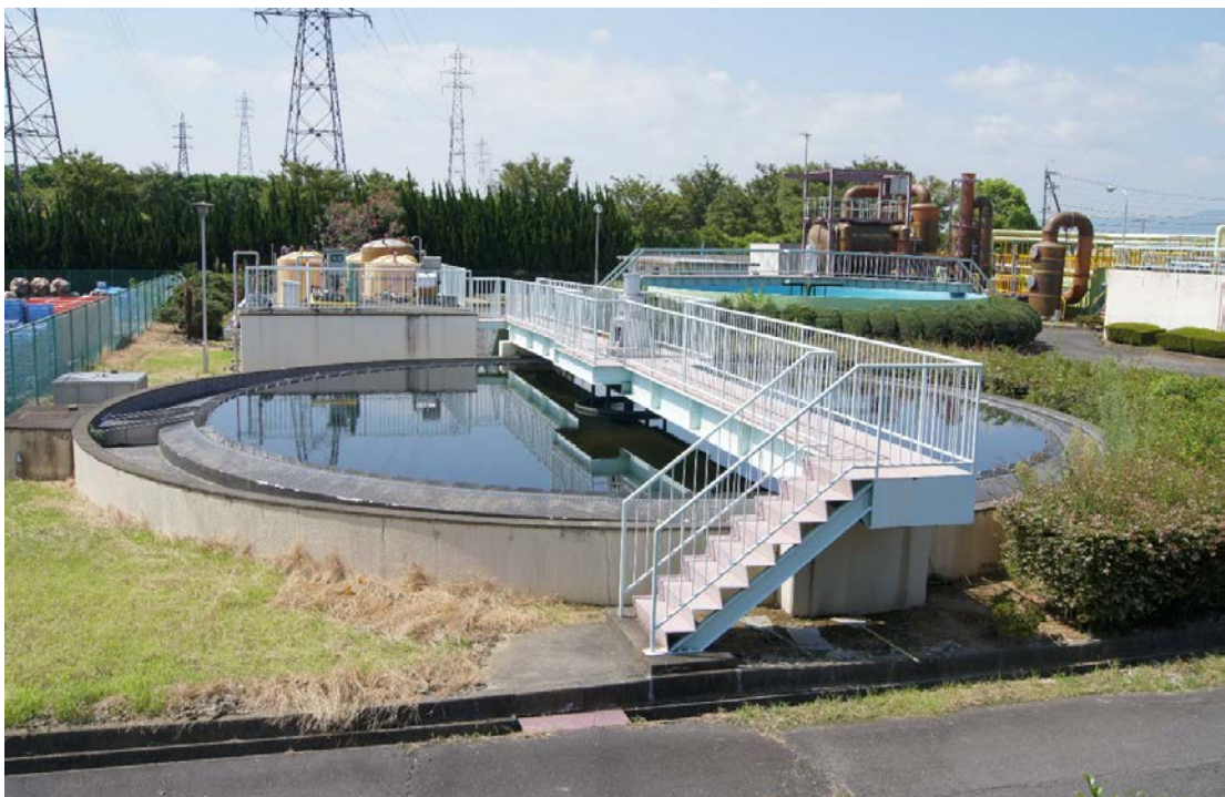
稲 沢 市 平 和 浄 化 セ ン タ ー
