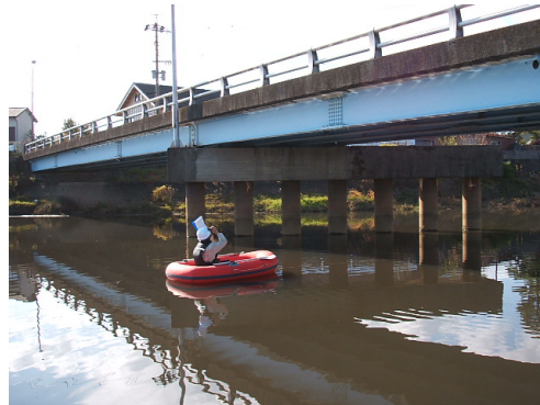
写真-3.2 専門業者による点検
