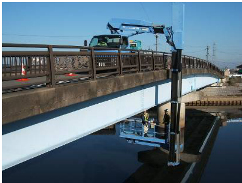
写真-3.1 職員及び専門業者による点検
