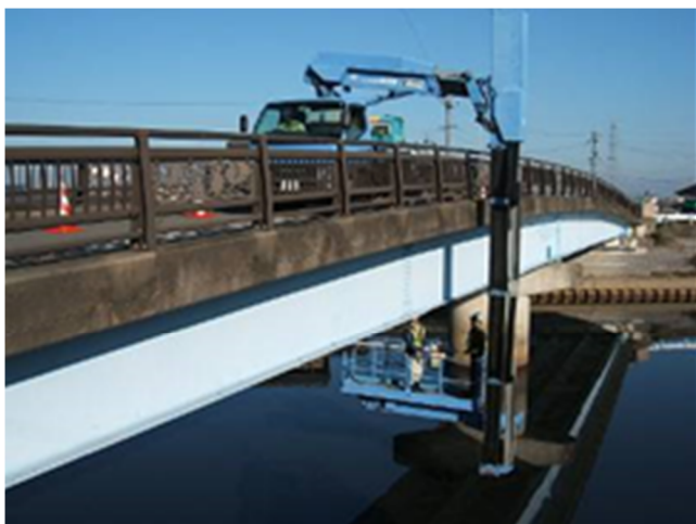
橋梁点検車による点検状況
