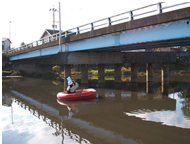
ゴムボートによる点検状況
