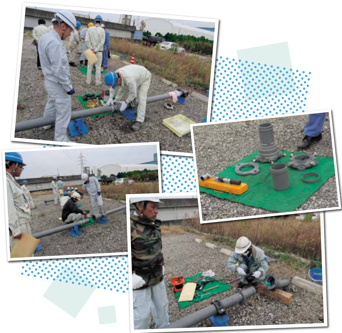
耐震管の接合講習会の様子
