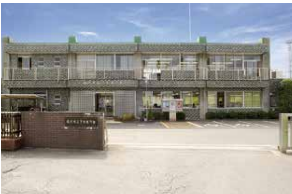
稲沢市上下水道庁舎
