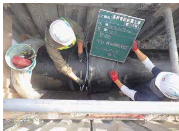
管路工事の様子
