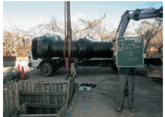
耐震管路の布設
