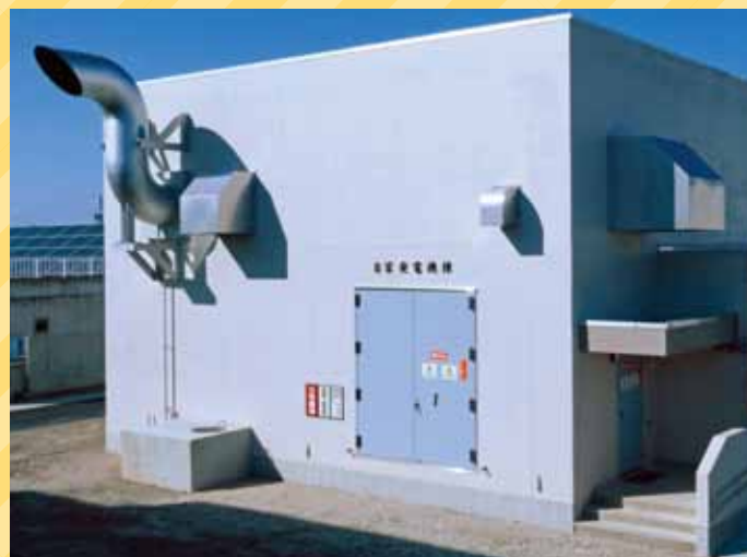
自家発電機棟
