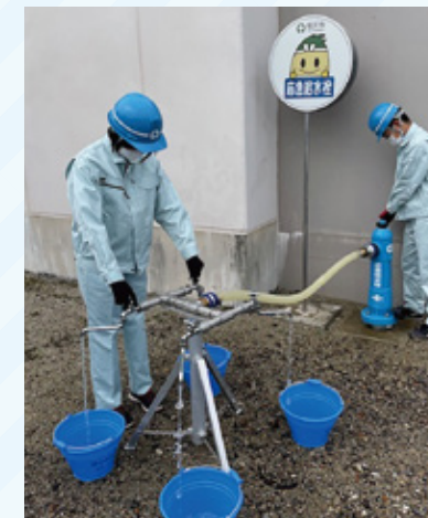
応急給水栓と給水装置
