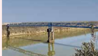
市内にかかる水管橋
