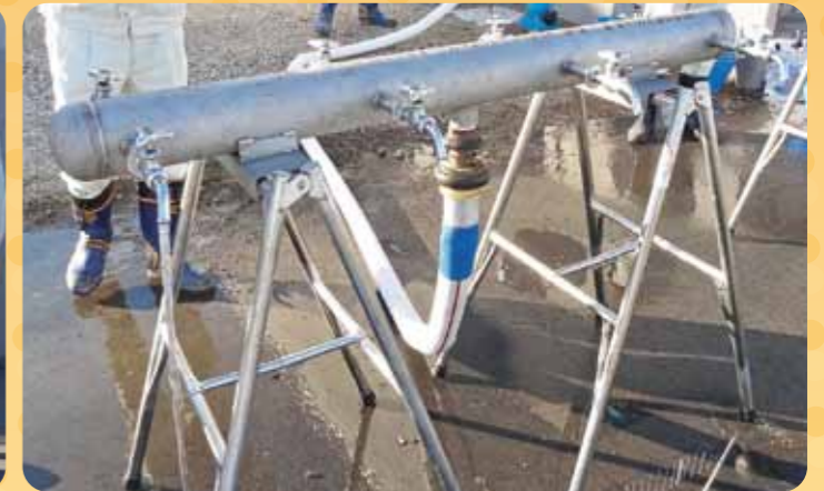
設営した給水装置の蛇口から水を使うことができます。
