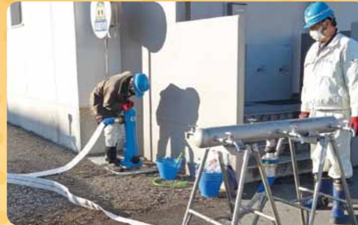
応急給水栓にホースを接続し、給水装置を設営します。
